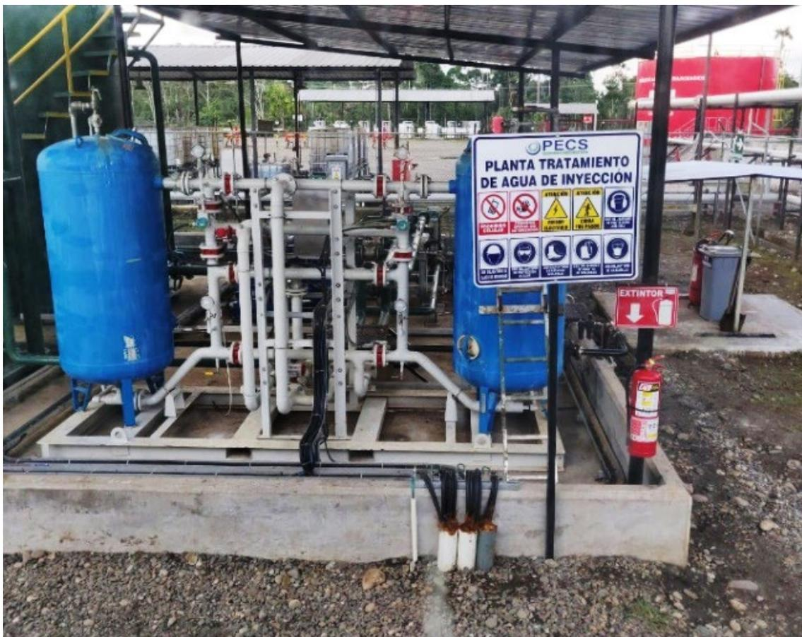
**PECS puso en marcha una planta de tratamiento de agua para inyección (PTAI)** en la que el agua del tanque de pulido ingresa a la PTAI con menos de 50 ppm de sólidos suspendidos totales, 50 ppm de aceite en agua y 10
